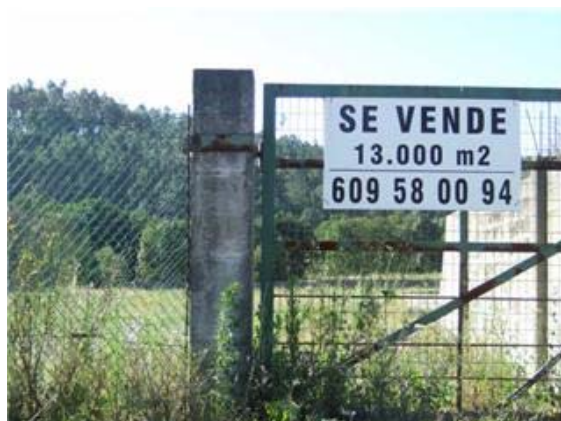
Estado actual de la parcela de Brenntag (vista 1)
